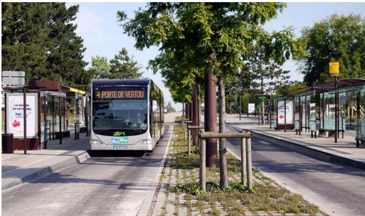
MYND 3.9 Lítil stöð við hraðvagnakerfi í Nantes í Frakklandi [6].
